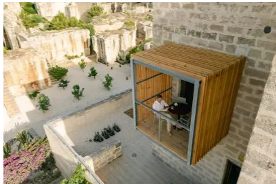
La loggia a sbalzo sulla cava
