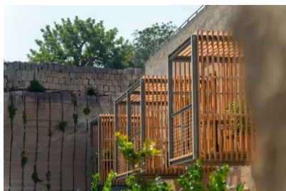
Il frangisole di legno sulla calcarenite
