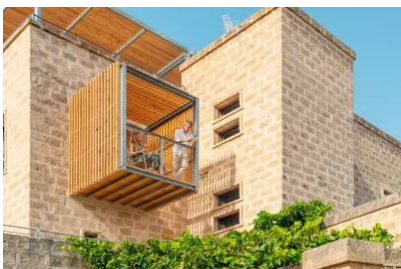
Il volume in legno sul fronte di pietra
